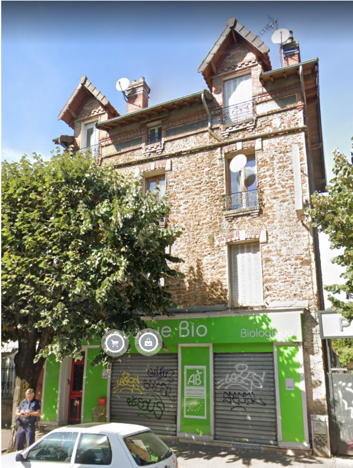
151, Grande Rue – 93250 Villemomble
